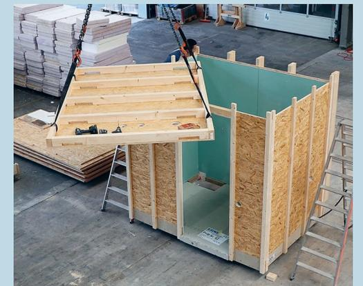
I bagni prefabbricati Easydock pesano circa 500 kg/m<sup>2</sup> e possono essere installati lateralmente o dall'alto nell'edificio grezzo.
